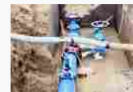
Siena: il 7 maggio lavori di manutenzione di AdF in via
